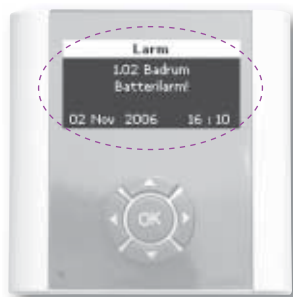
I manöverpanelens display visas golvvärmesystemets status.
