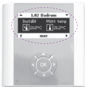
Från manöverpanelen övervakas och ändras inställda värden.
